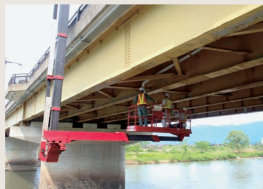
橋梁点検車による損傷点検
