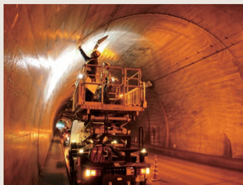
トンネル点検
