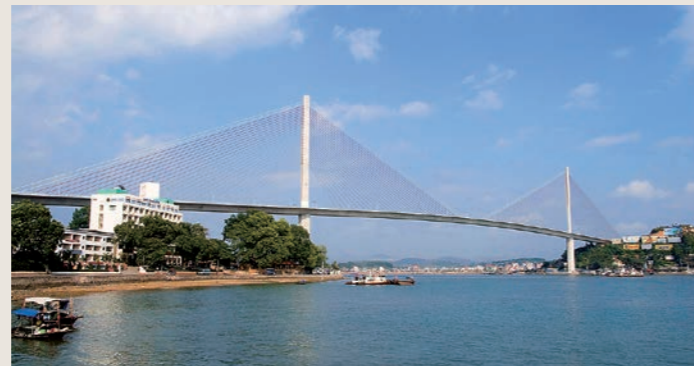
BaiChay 橋（田中賞受賞）：世界最大支間を有する一面吊PC斜張橋
