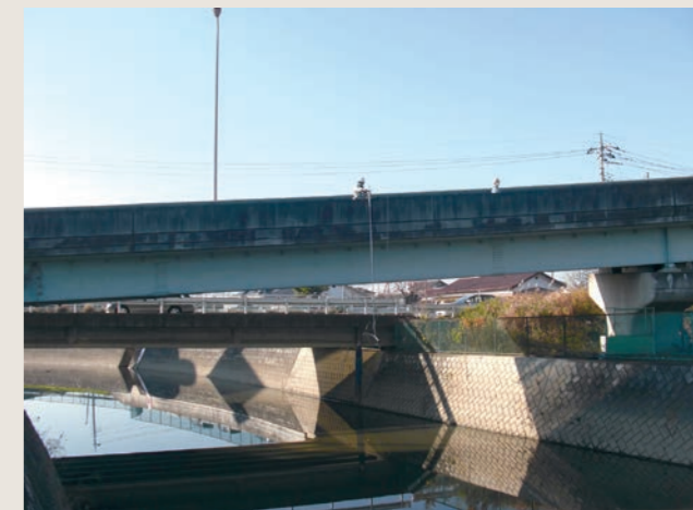
ボールカメラによる橋梁点検
