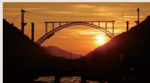
広島空港大橋（田中賞受賞）：架設中の広島空港大橋
