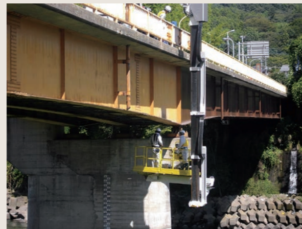
大型点検車による橋梁点検
