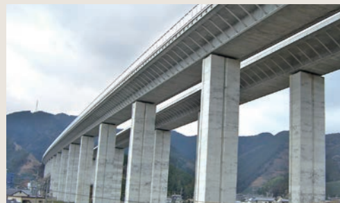
内牧高架橋（田中賞受賞）：主桁断面分割方式プレキャストセグメント工法を用いたストラット付PC箱桁橋
