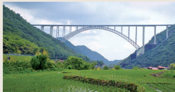
広島空港大橋（田中賞受賞）：ブレースドリブアーチを有する国内最大支間の鋼アーチ橋
