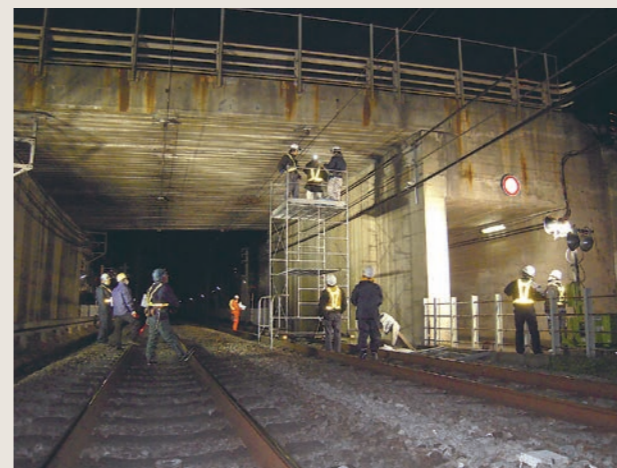
ローリングタワーによる橋梁点検
