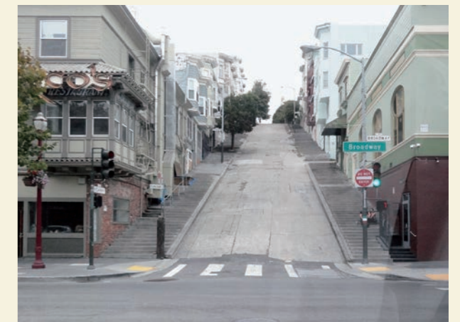
写真8 両側の歩道が階段の急坂
