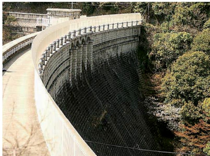
写真1 天端形状（曲線形）
