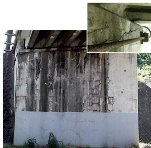
写真1 橋台A(正面に堅壁、側面に翼壁)と、上部の水平ひび割れ
