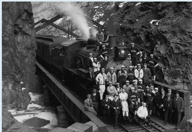
写真3 狭軌にレールを1本追加して標準軌でも使えるようにしてある
