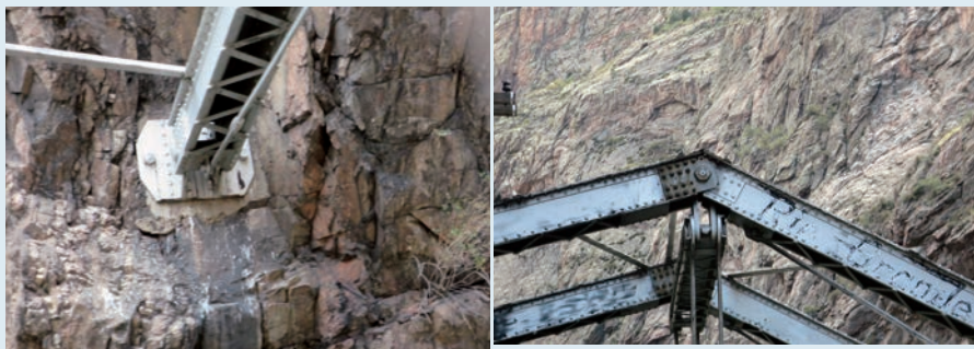
写真4 ハンギング・ブリッジの支承部と吊り部
