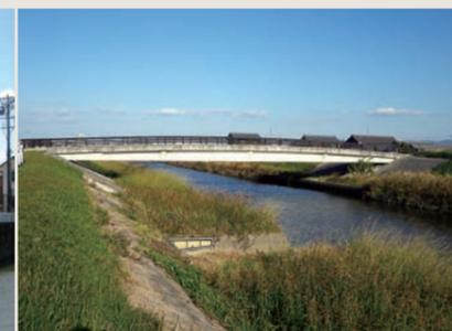
菱池橋（ポストテンション単純床版桁（パイプ）橋長L= 42.40m）
