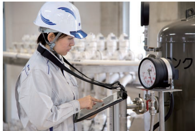
写真4 浄水場での点検作業
