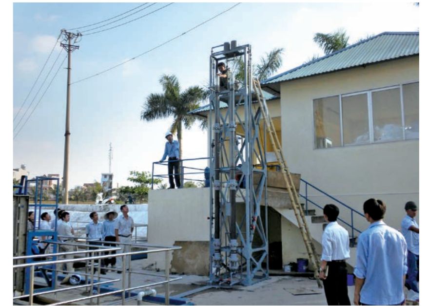
写真3 JICA草の根技術協力事業でのデモプラントの設置
