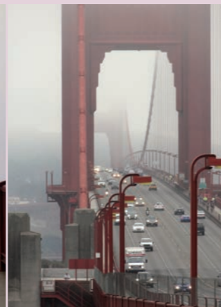
写真5 マリン郡から望む6車線の橋
