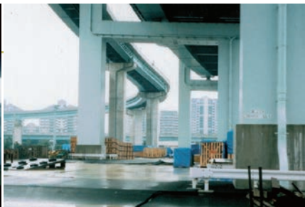
写真2 地盤の不同沈下が生じた埋立地盤では類似の高架道路橋脚に揺れの被害が全く見られなかった
