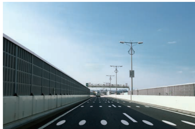
図5 首都高速道路に使われているオプティカルドットシステム（提供：韓 亜由美氏（スタジオ ハン デザイン代表取締役 / 公立前橋工科大学教授））
