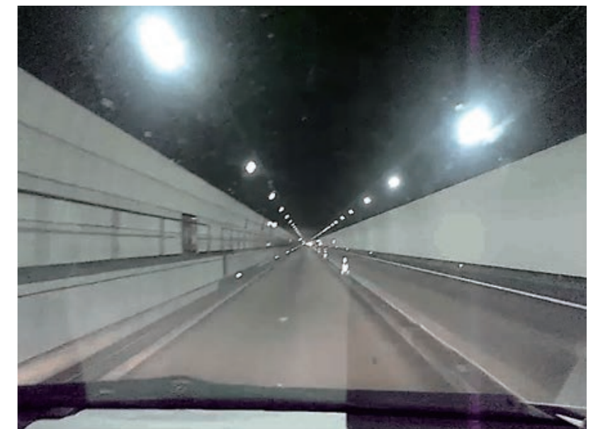
図3 トンネル内部。壁面のラインを水平線であるかのように認識してしまい、道路面も水平だと錯覚してしまう。実際は上り坂である(阪和自動車道)
