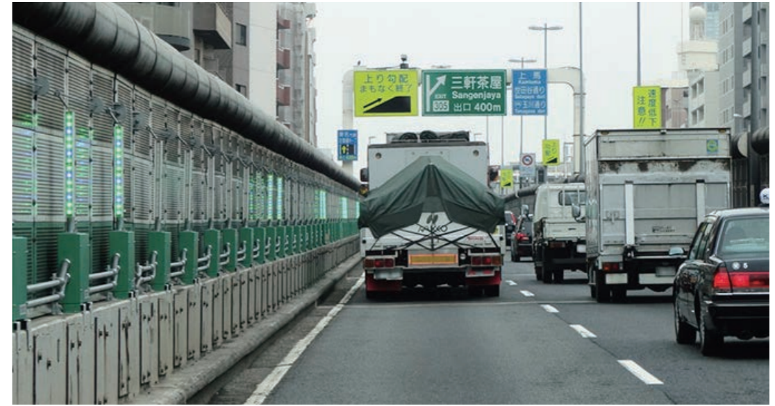
図6 エスコートライト。壁面の緑のライトが進行方向に流れる（提供：首都高速道路株式会社）
