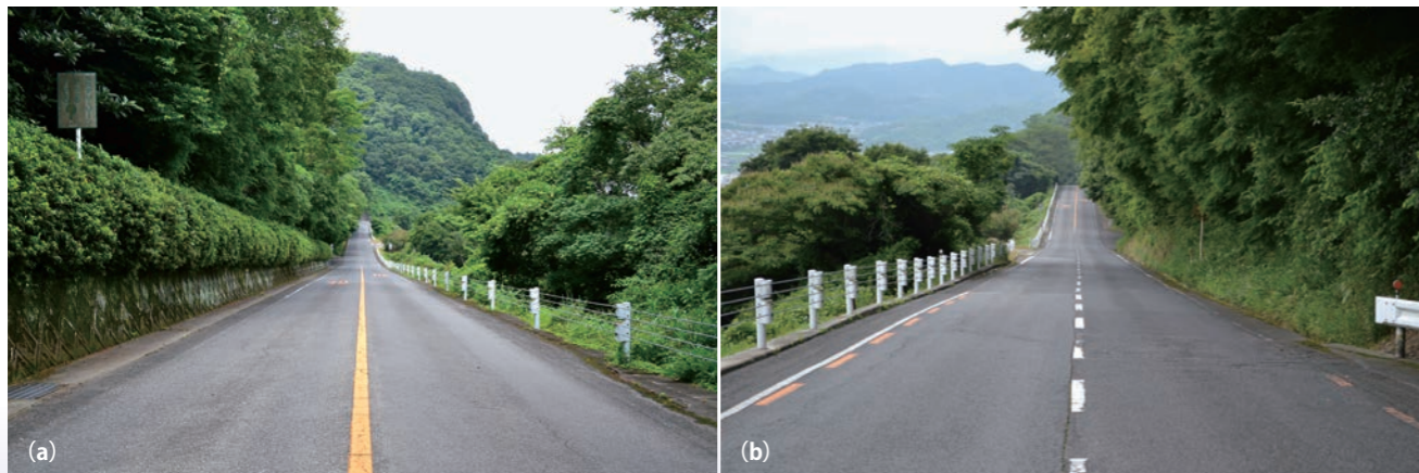
図1 縦断勾配錯視の例：香川県にある屋島ドライブウェイ(協力：屋島ドライブウェイ株式会社)
