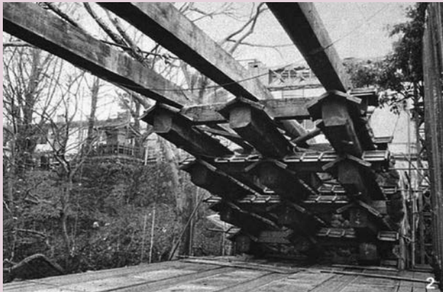
写真4 桔木が現在より一列多い1984年解体中の猿橋
