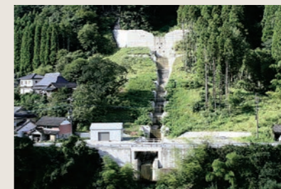
矢形処川砂防えん堤・溪流保全工（大分県中津土木事務所）
