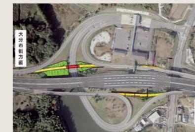
杵築IC(空港道路)
