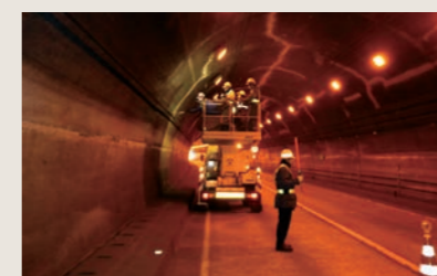
国道210号トンネル点検
