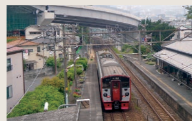
浜脇跨線橋(JR日豊本線)
