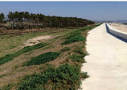
写真5 完成から約1年半経過した裏法盛土部
