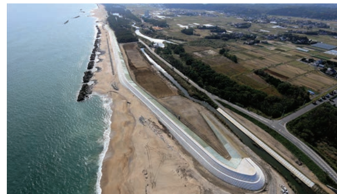
写真1 完成したCSG堤(北から望む) 3)
