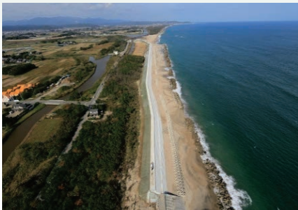
写真4 CSG堤を南側から鳥瞰する (H25.11) 3)
