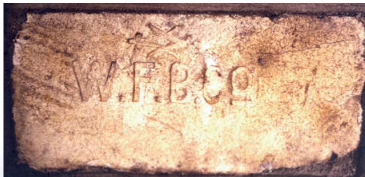
写真1 神戸のハンター邸2階暖炉に使用されている白煉瓦
