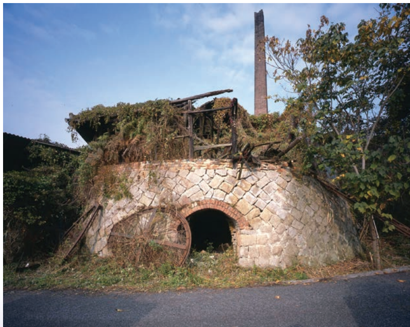
写真6 広島県福山市の旧西山煉瓦ホフマン窯
