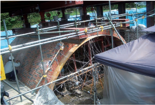
写真4 載荷試験の様子
