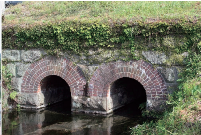
写真2 丸池湧水暗渠
