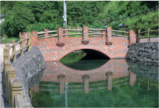
写真5 丸池地区橋梁(人道橋)
