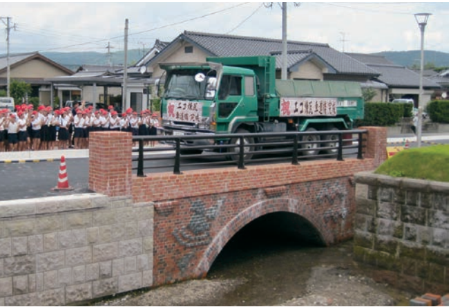
写真6 駅前道路橋梁(車道橋)
