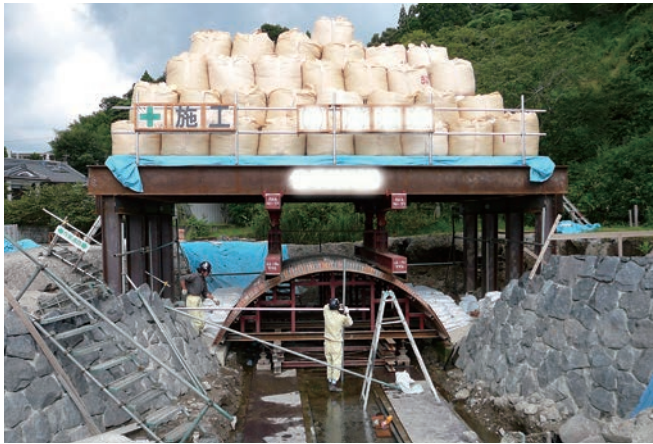
写真3 載荷試験装置の状況
