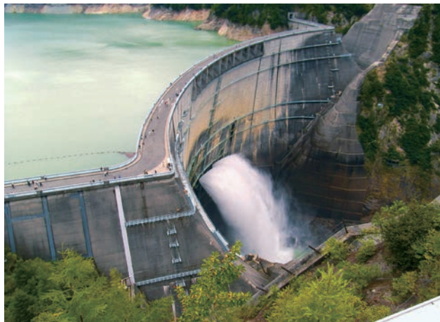
写真2 電力で日本の経済発展を支えた黒部ダム 1963年完成
