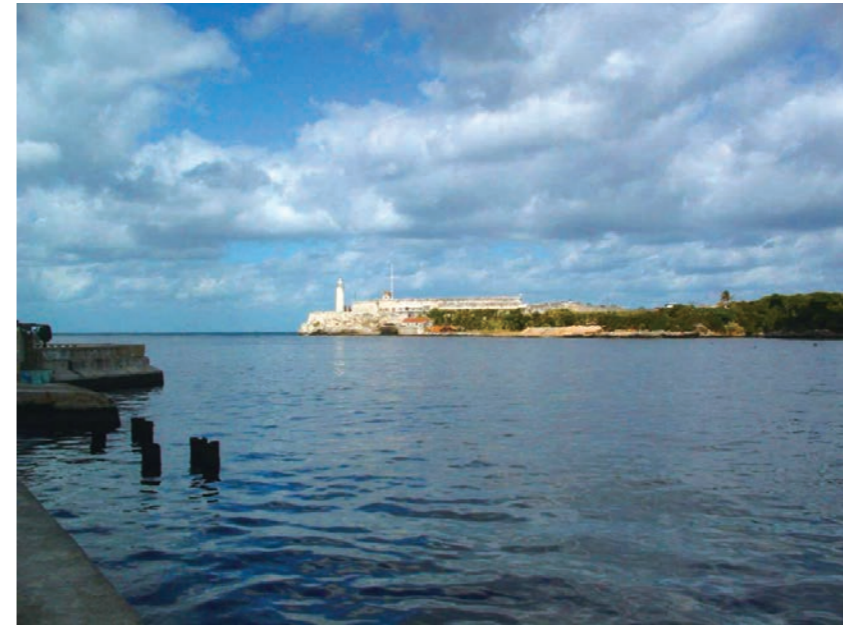
写真7 キューバ、ハバナ港口のモロ要塞。港口を隔てたハバナ市から全景を望む
