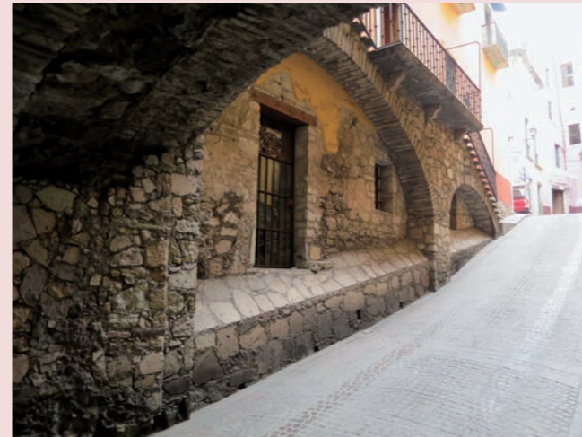
写真6 開業したレストランとトンネルへ続く斜路
