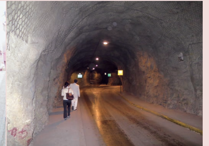
写真7 当時の鉱山技術で掘削されたトンネル
