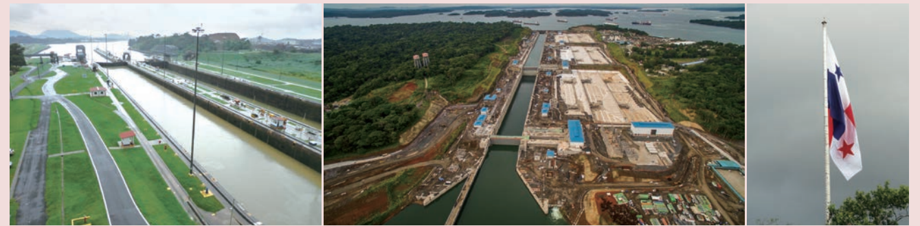
写真6 ミラフローレス閘門
