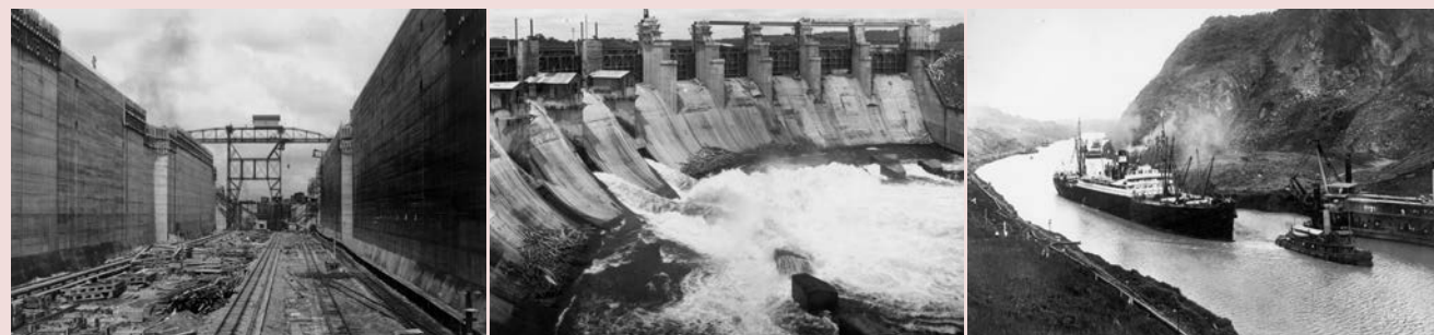
写真3 ミラフローレス閘門の建設(1911年) 写真4 建設中のガトゥン・ダム余水吐(1913年) 写真5 初通過するSSアンコン号(1914年)
