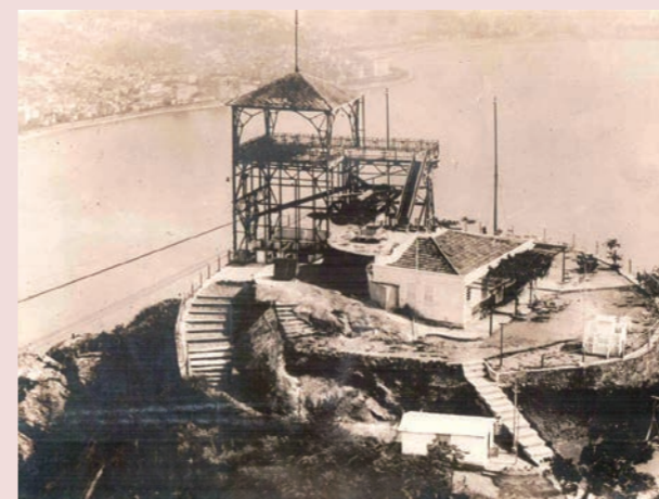
写真2 ボン・デ・アスーカル駅の工事
