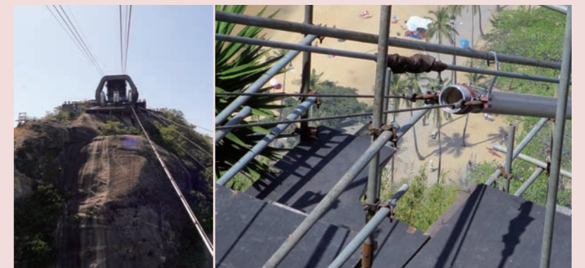
写真8 ポン・デ・アスーカル駅 写真9 下水道パイプの添架工事
