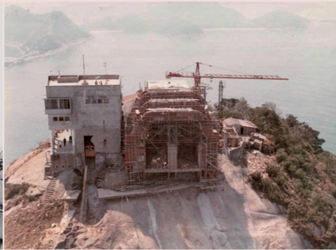
写真5 ポン・デ・アスーカル駅のリニューアル工事
