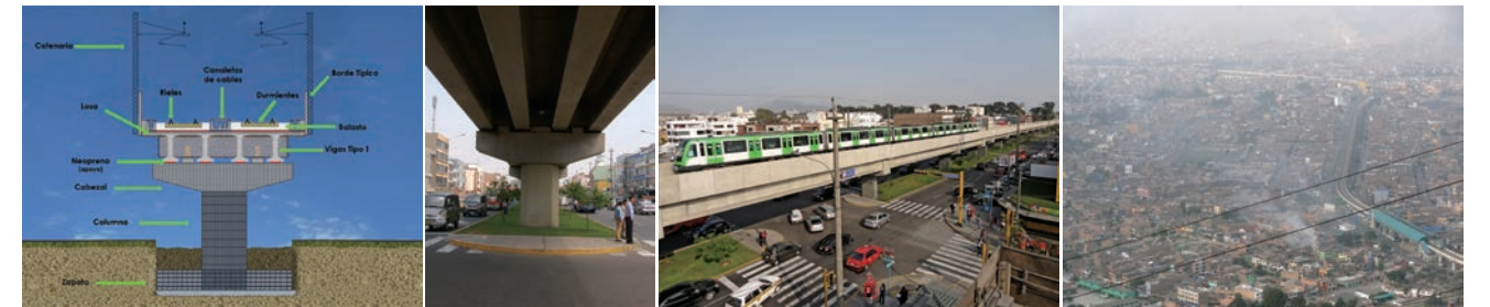
図3 1号線の標準断面図 写真1 1号線の高架橋橋脚 写真2 LA CULTURA 駅南側の高架鉄道 (AATE社屋上から) 写真3 サン・クリストバルの丘から見える1号線 (北部)
