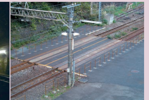
写真10 熱海口付近に設けられた軌陸車載線設備
