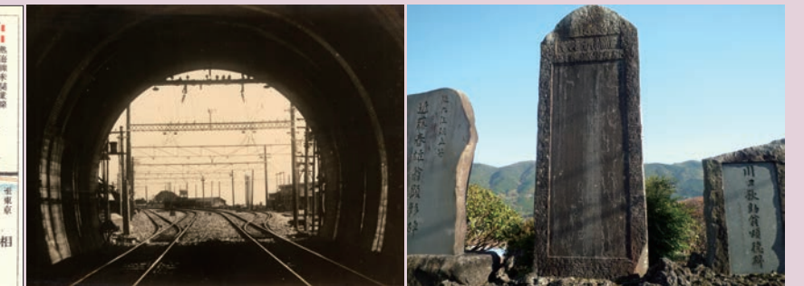
写真1 丹那トンネル内部より熱海口を望む 写真2 湯水救済記念碑(中央)
