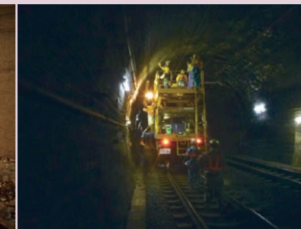
写真9 軌陸車を使用したトンネル内の打音検査状況
