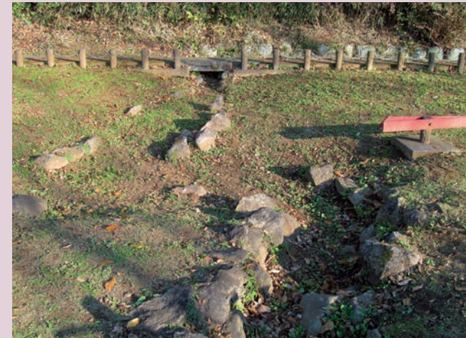
写真6 丹那断層公園に保存された断層の横ずれの様子（断層に直交する水路の石積みも横ずれ）
