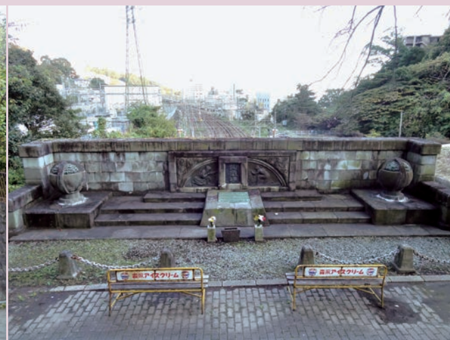
写真5 熱海側坑口の上に設けられた殉職碑
