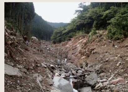
志谷川被災時
