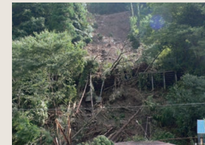
柿坂急傾斜被災時
