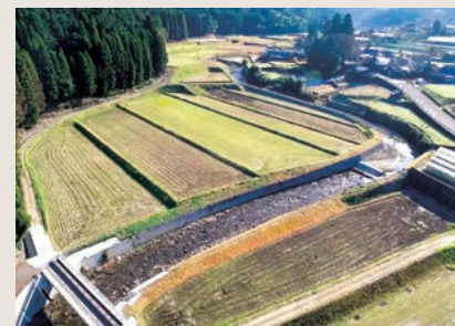
春田川施工後1
