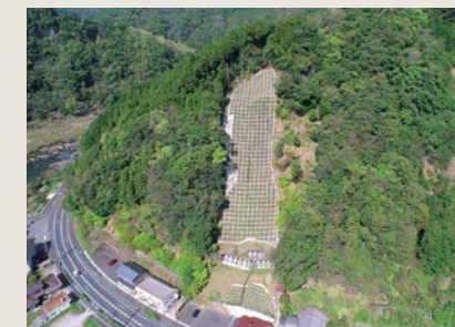
柿坂急傾斜完成
