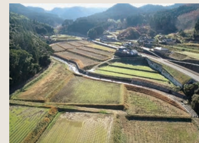
春田川施工後2
