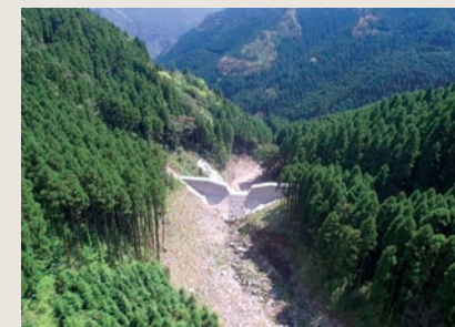
志谷川4号砂防ダム
