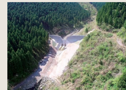
志谷川5号砂防ダム
