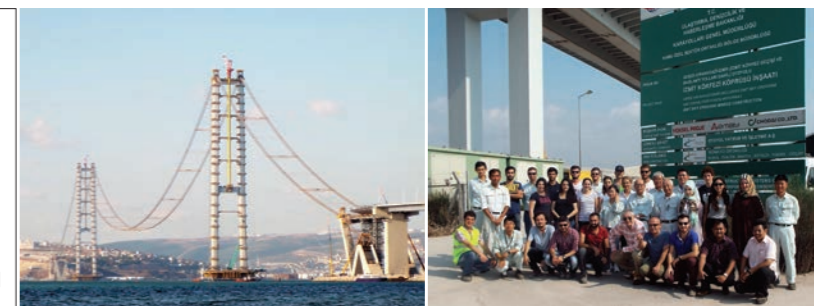
写真1 イズミット湾横断橋の建設状況 (2015年9月)
