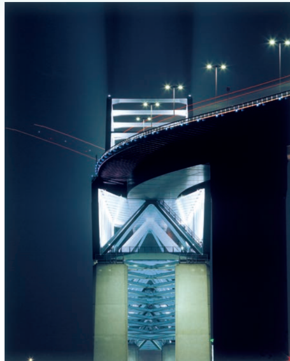
「支える構造美」 神奈川県 上飯坂 真 (撮影地：東京都江東区)
