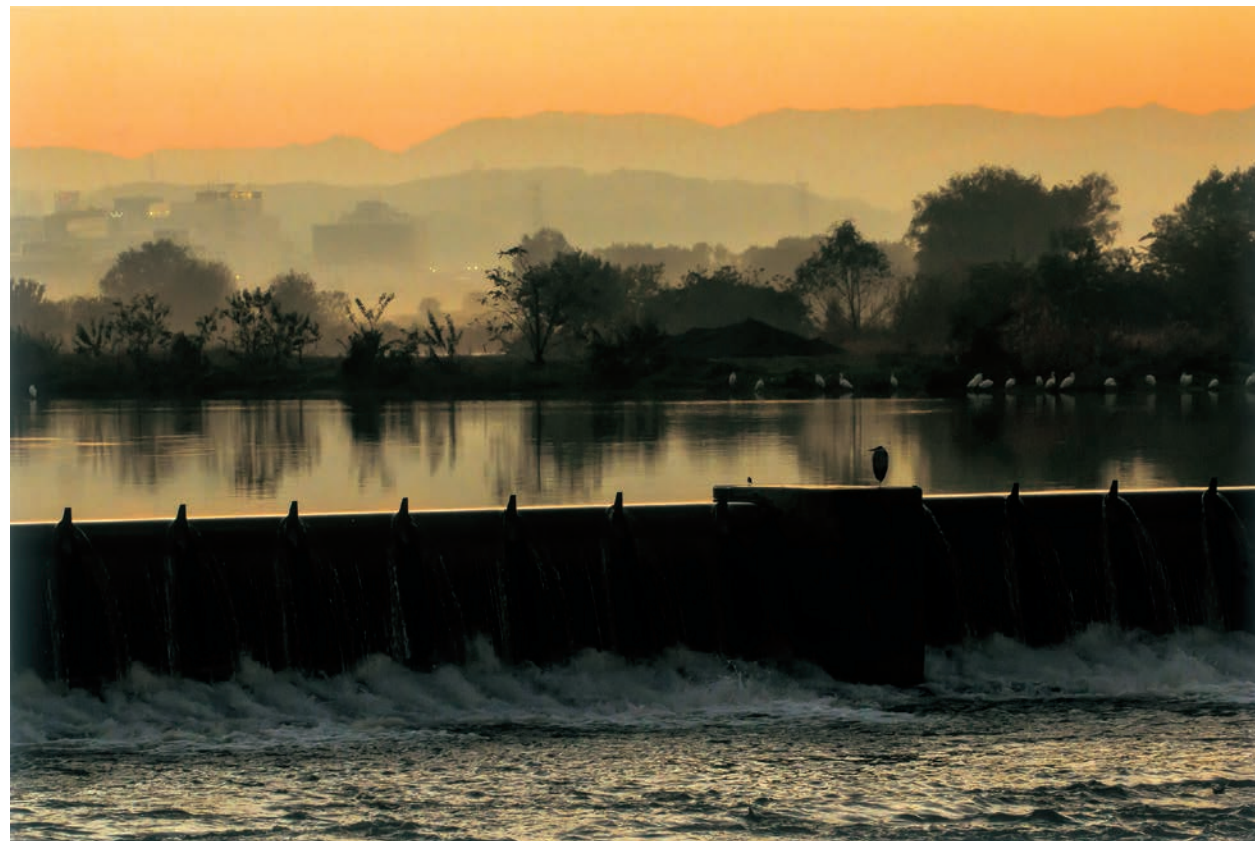
「暮れゆく堰堤」 神奈川県 松山 進 (撮影地：東京都稲城市)
