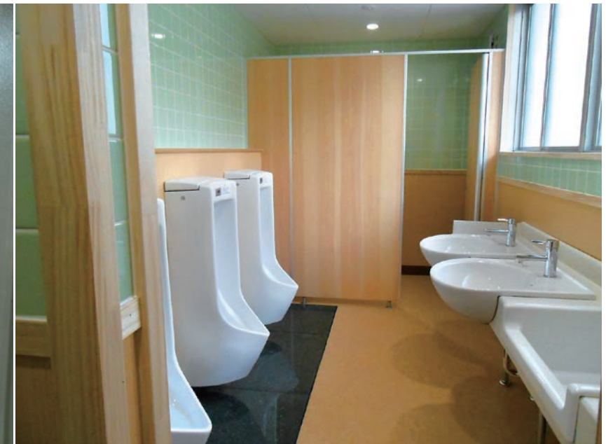
写真4 改修後のトイレ(中学校)
