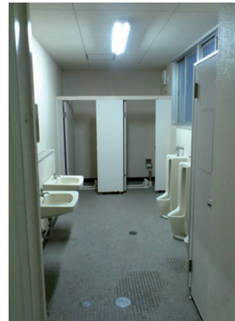
写真3 改修前のトイレ(中学校)
