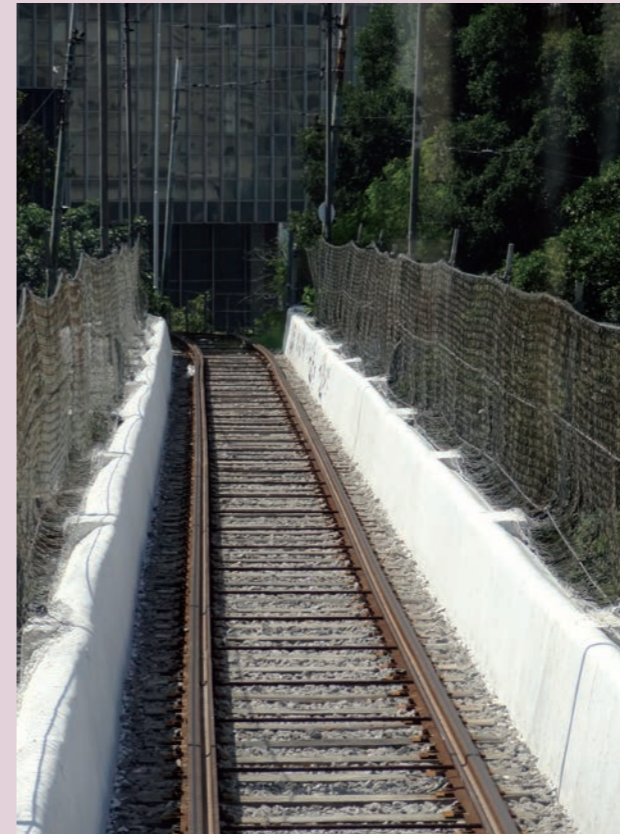
写真3 軌道数となっているカリオカ水道橋の橋面
