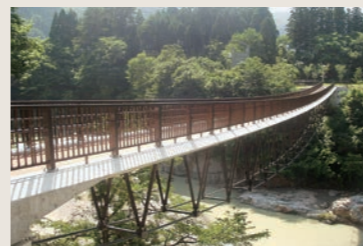
手取峡谷の景観に配慮した吊橋「大巻どんと橋」
