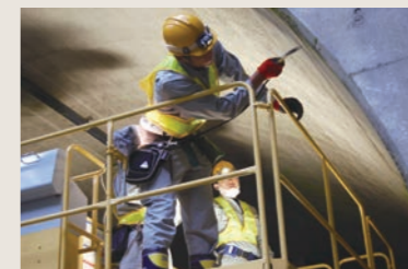
コンクリート構造診断士によるトンネル点検
