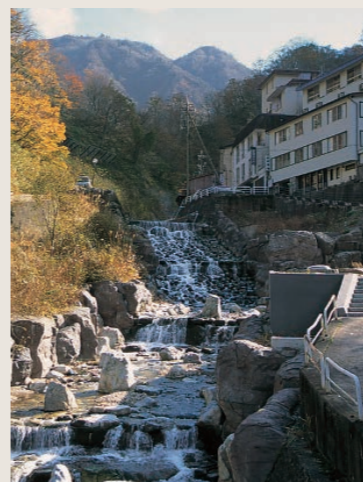
擬岩と自然石で修景した砂防施設【中宮温泉】
