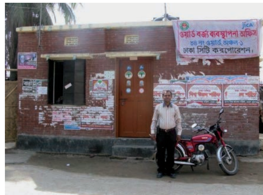
写真1 建設したワード清掃事務所
