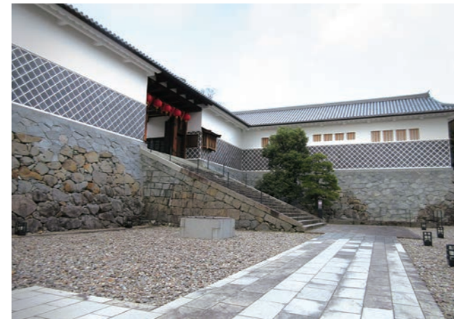
写真2 横から望む奉行所の階段（2002年に実施された奉行所跡の発掘調査で、建物の部分として唯一出土した、長崎奉行所正面の階段部分）
