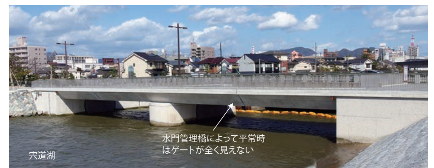
写真2 宍道湖側（岸公園側）から見た際の天神川水門
