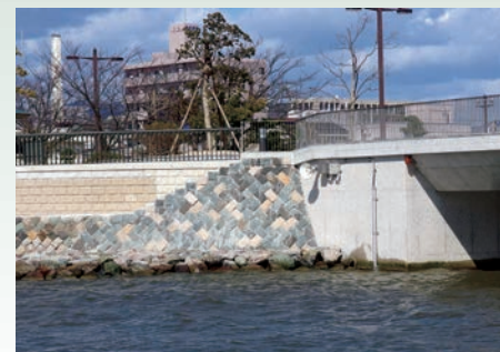
写真7 水門左岸側取付護岸
