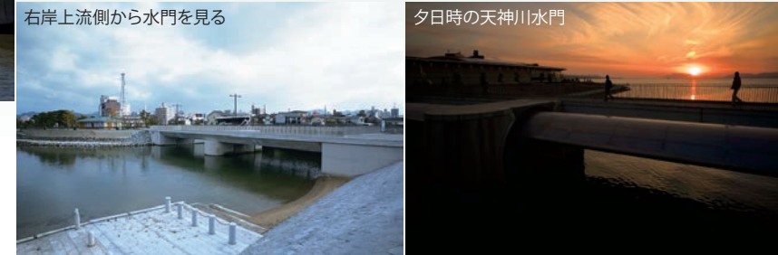
写真8 天神川水門完成写真
