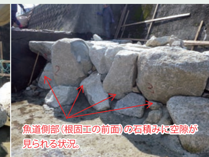
写真4 石材間の空隙
