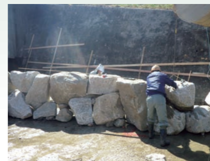
写真3 施工指導状況
