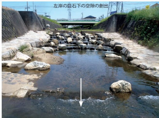
写真7 左岸側の根固工によるカバーの創出 (全景)
