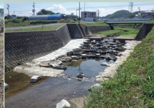
写真2 魚道施工後(落差=0.3m/1段)
