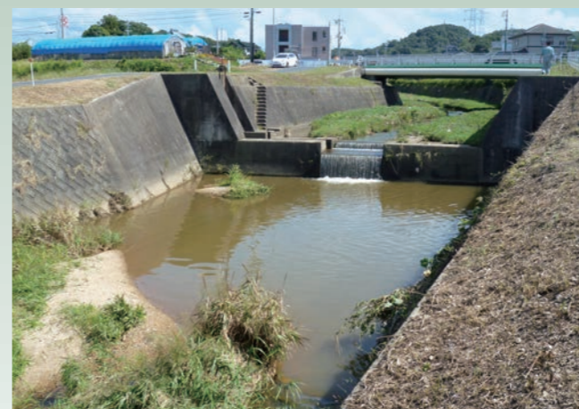
写真1 魚道施工前(落差=1.4m)
