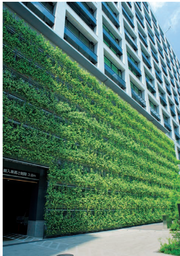
写真4 植物でつくるカーテンウォール。一般的なカーテンウォールと同等の強度性能を持つ
