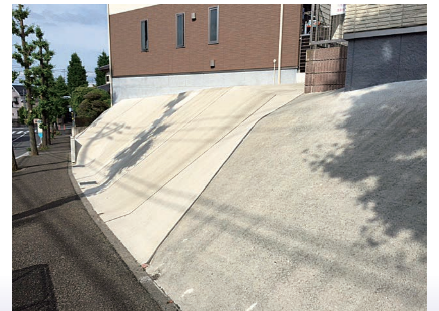
写真5 周りをコンクリートで固めた建物と強剪定された街路樹
