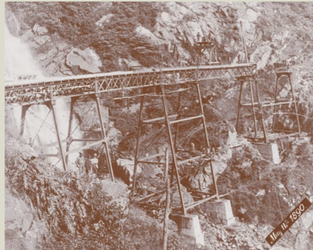
写真4 建設中のストーンクリーク橋
