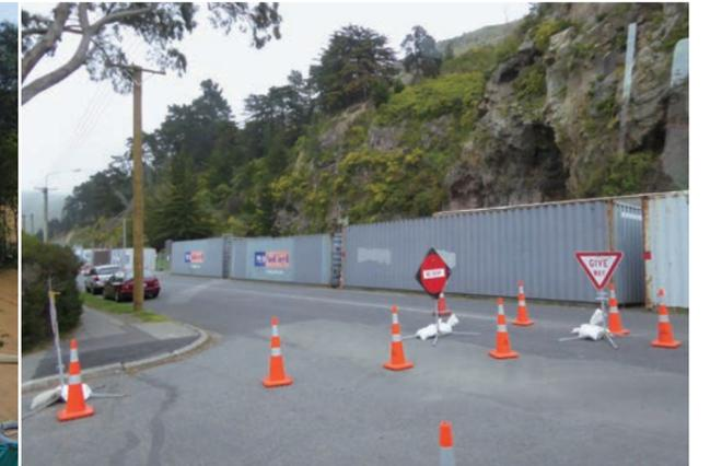
写真7 防護壁代わりのコンテナ
