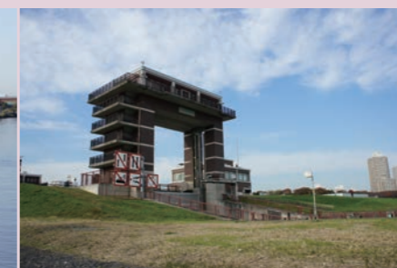
写真4 荒川ロックゲート
