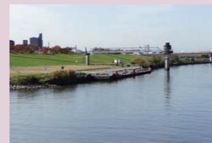
写真3 岩淵リバーステーション
