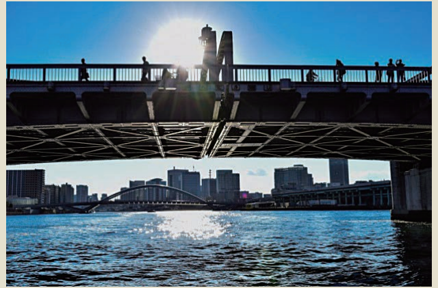
「勝どき橋に日が入る」 東京都 大野 絵理 (撮影地：東京都中央区)
