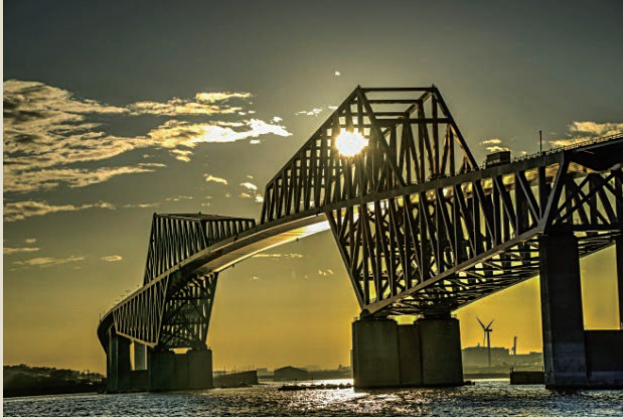
「黄金に輝く東京ゲートブリッジ」 兵庫県 石田 大晴 (撮影地: 東京都江東区)
