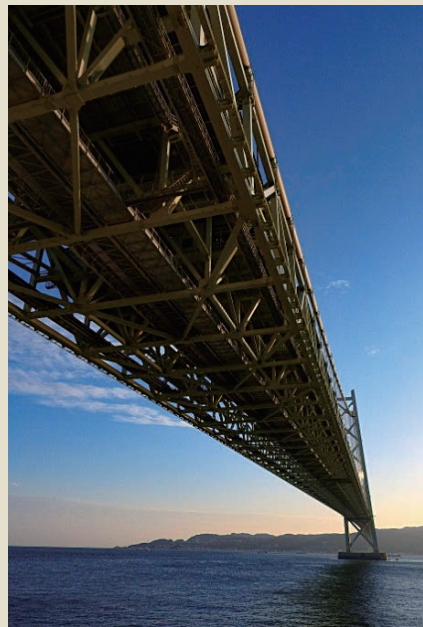
「この橋は」 大阪府 芝谷 開 (撮影地：兵庫県神戸市)
