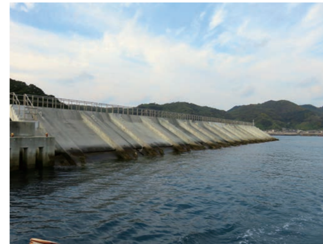
写真3 本浦漁港防波堤（正面）
