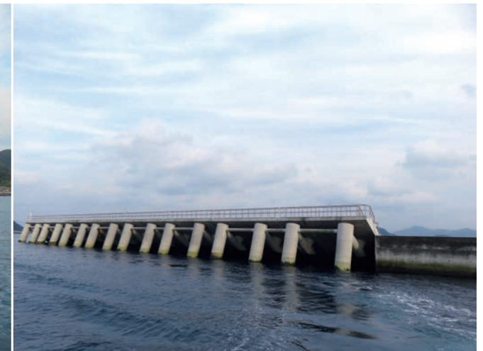
写真4 本浦漁港防波堤（背面）
