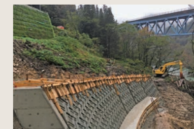
建設中の湯谷川小水力発電所 (自社事業)
