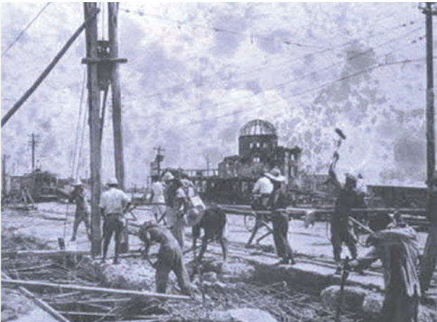
写真2 相生橋の復旧工事（1946年）
