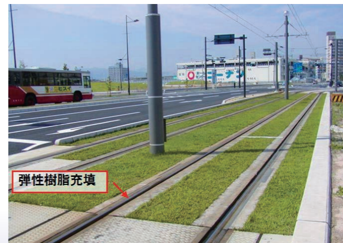
写真7 樹脂固定軌道と芝生軌道
