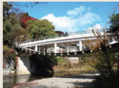
馬見原橋（鋼変形フィレンデル橋）熊本県
