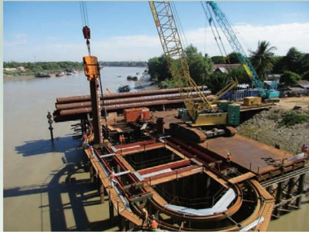
写真4 鋼管矢板の打込み
