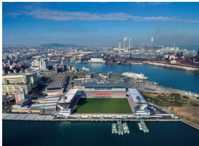
写真1 スタジアム外観
