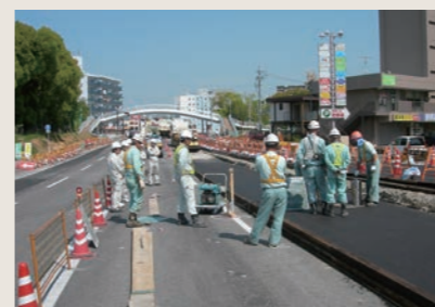
現場施工講習会
