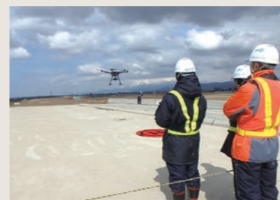
i-Construction (UAVによる写真測量)
